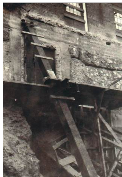
Figura 50 - Un caso di underpinning (sottofondazione) di un edificio oggetto di una visita tecnica nel quartiere Arlington, dal quale si gode una bella vista di Boston (foto R.J., 1952).
