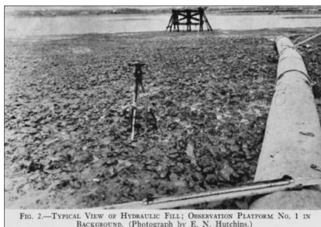
Figura 52 - Immagini della Boston Bay e particolari dei lavori di costruzione della colmata sulla quale è fondato il Logan International Airport.
