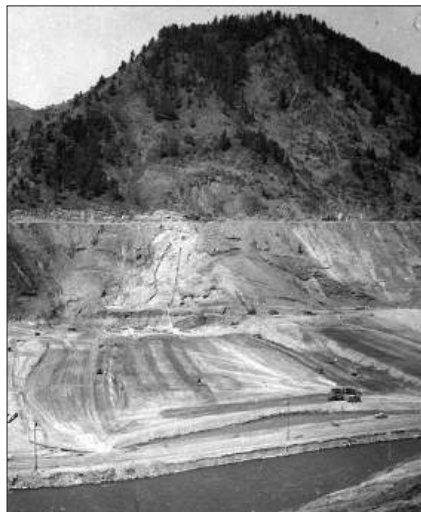
Figura 63 - Immagine del cantiere della diga di terra Palisades in costruzione sullo Snake River, Idaho (foto R.J., 1953).
